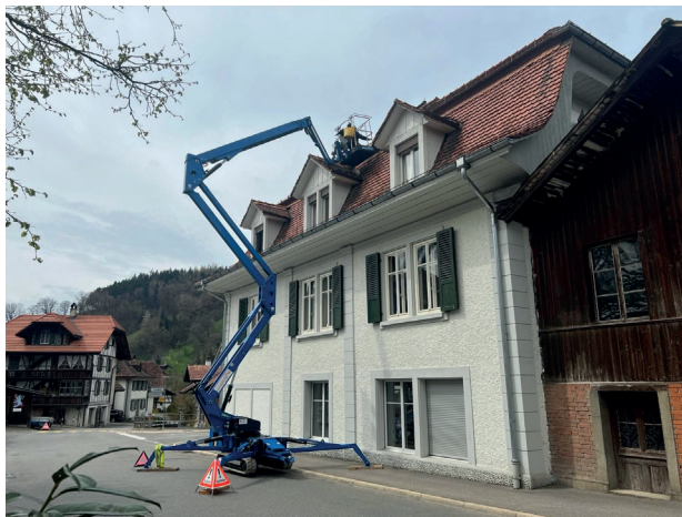
Arbeiter auf einer Raupenhebebühne bei Dacharbeiten
