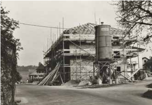
Das neue Wohn- und Geschäftshaus im Mai 1959
