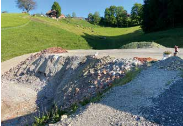
Fachgerechter Einbau des angelieferten Inertstoffmaterials
