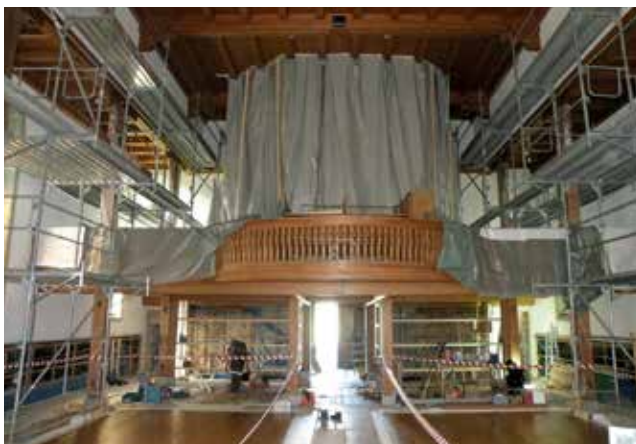
28 Während des Umbaus
