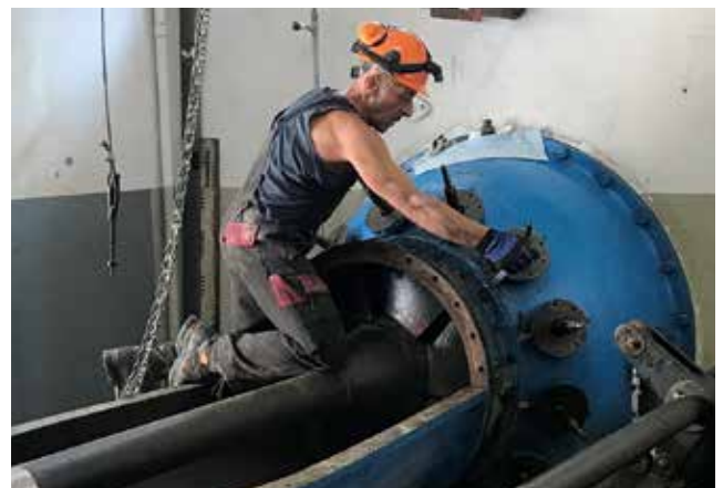
Adrian bei der Demontage einer Kaplan turbine (Jg. 1939, Theodor Bell, Kriens)
